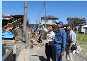
熊谷市の竜巻被害現場で
