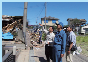
熊谷市の竜巻被害現場で
