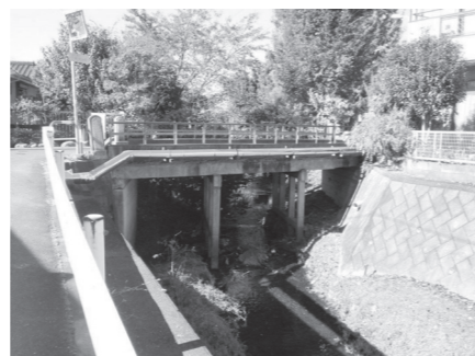
柳瀬川半立橋の改修・改良にも取り組んでいます。
